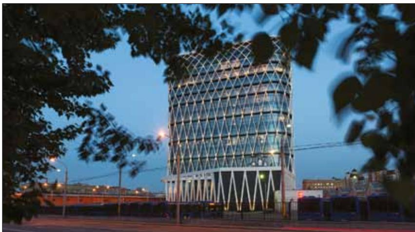
Рис. 6. Структура сетчатой оболочки фасадов БЦ «Земельный» подчеркнута с помощью света
